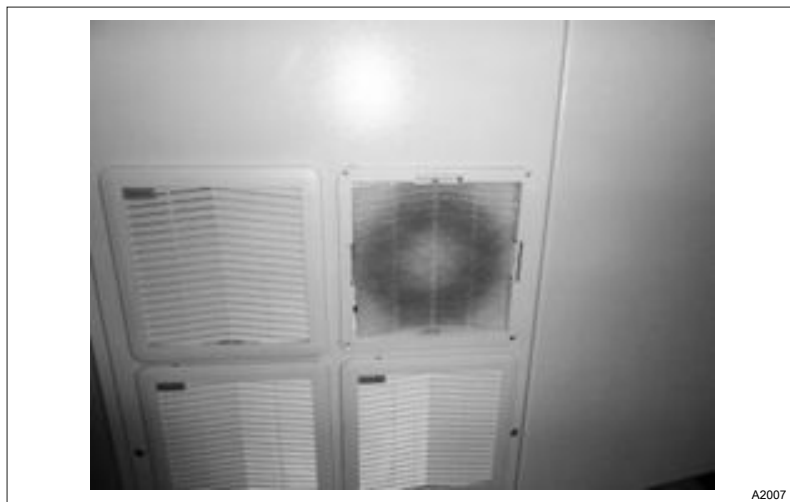
Rys. 83: Czyszczenie filtrów
