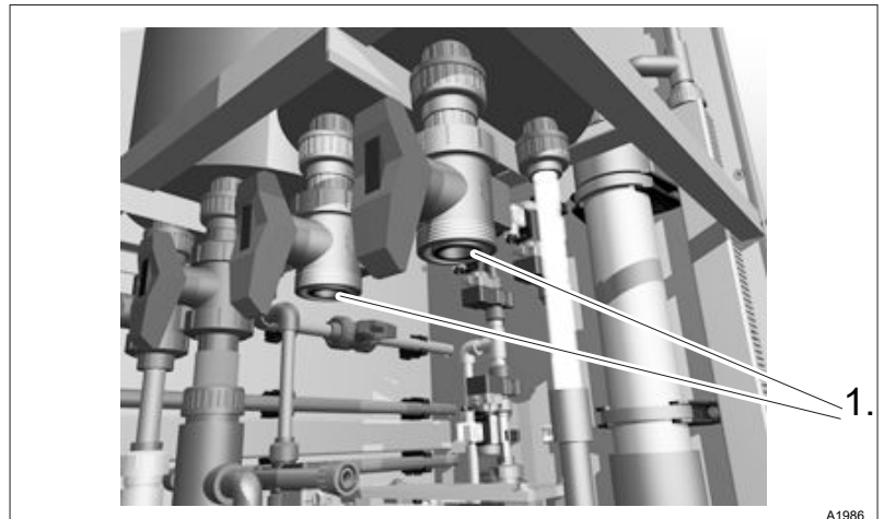
Rys. 63: O-ringi kurków odcinających pod zbiornikiem ługu
